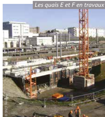
Les quais E et F en travaux
